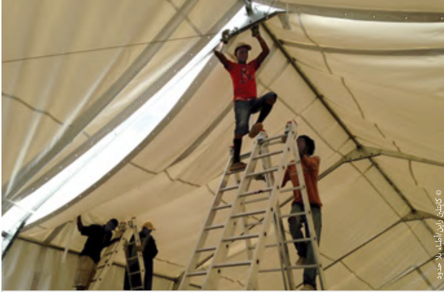
© كاتلين ران/أطباء بلا حدود فرق البناء تقوم بتشديد ما أصبح لاحقاً أحد أجنحة مركز مكافحة إيبولا الثالث التابع للمنظمة والواقع في ضواحي مونروفيا.
